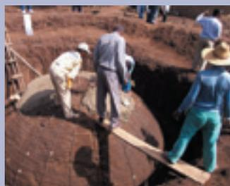
Un dôme en béton d'une capacité allant jusqu'à 66 000 litres.
